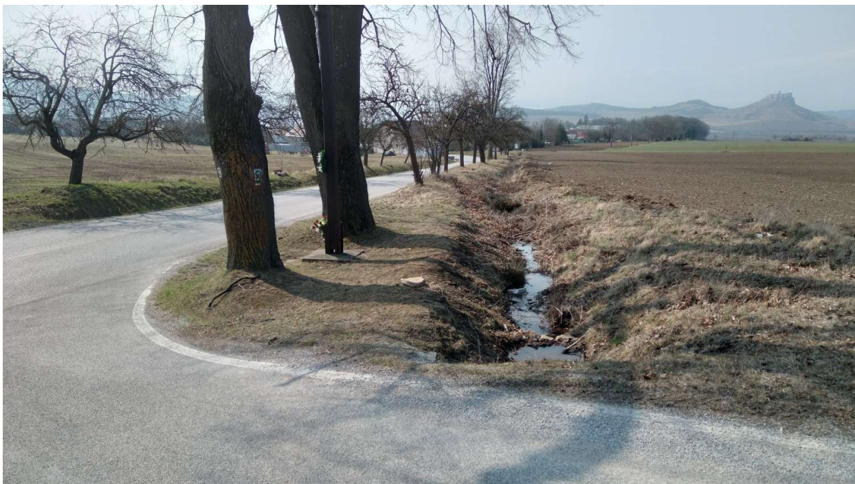
Bijacovce, 3-2025. Pohľad z priestoru križovatky ciest III/3216 a III/3203 na cestu III/3216 so stromoradiím vstupujúcu do obce a koryto paralelne tečúceho Bijacovského potoka. V pozadí Spišský hrad.
